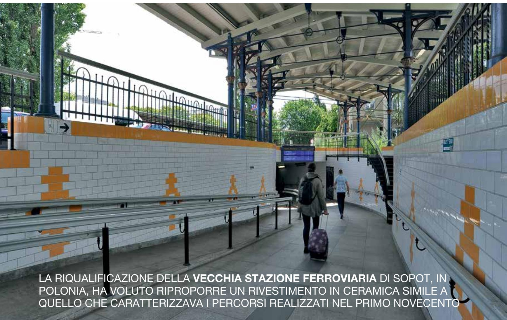
LA RIQUALIFICAZIONE DELLA **VECCHIA STAZIONE FERROVIARIA** DI SOPOT, IN POLONIA, HA VOLUTO RIPROPORRE UN RIVESTIMENTO IN CERAMICA SIMILE A QUELLO CHE CARATTERIZZAVA I PERCORSI REALIZZATI NEL PRIMO NOVECENTO
